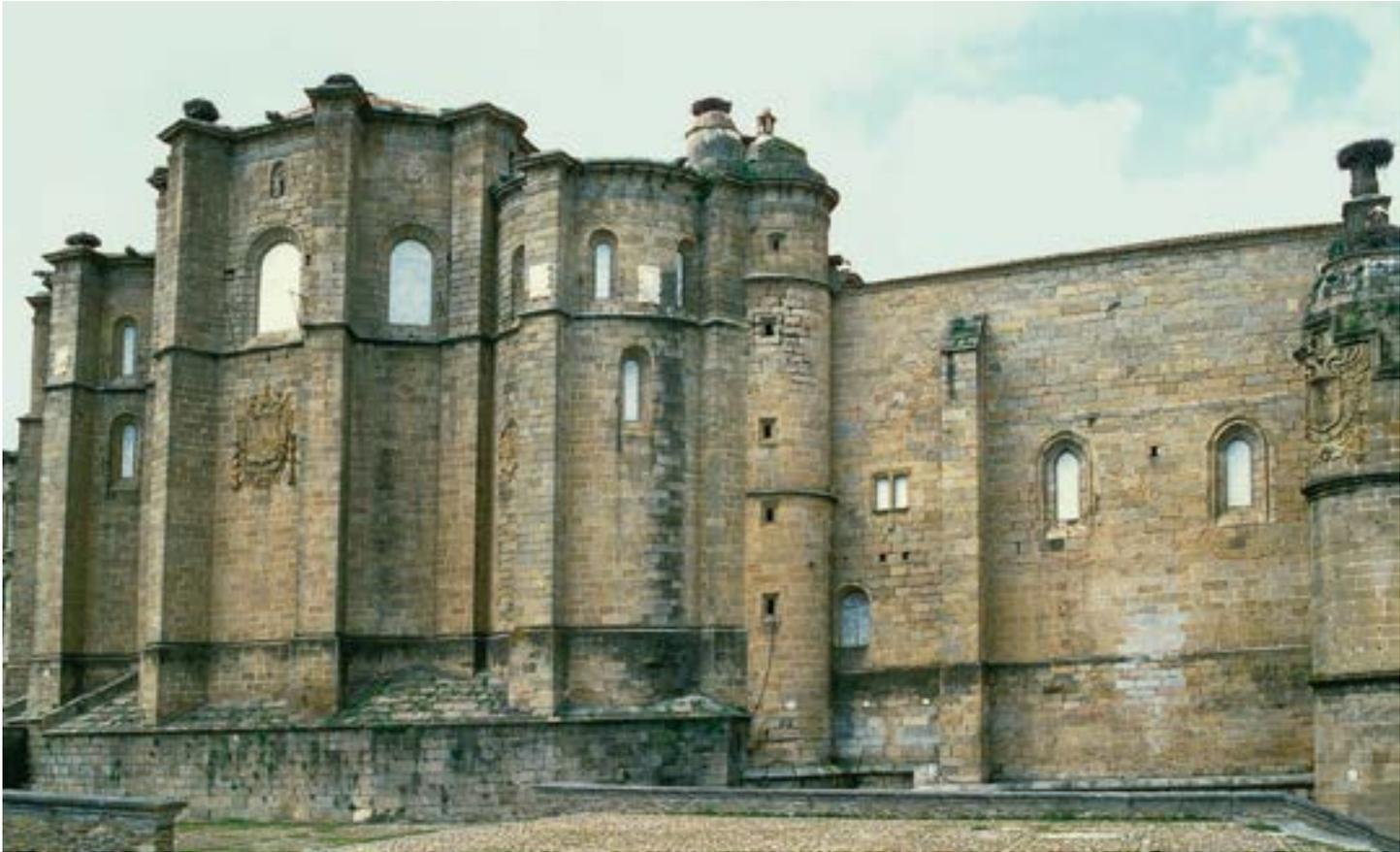
FIG. 171 Exterior oriental del conjunto monástico. Sobre la unión de los ábsides con las dependencias claustrales destaca el volumen cilíndrico correspondiente a la «escalera de San Gil», que comunica la sacristía (iluminada por amplio ventanal) con la sobresacristía (con ventana ajimezada)
